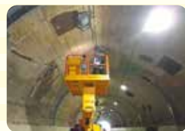
トンネル工事
