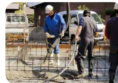
作業現場風景
