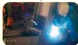
4.溶接 組立てた部材を本溶接します。
