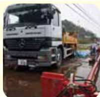
ドイツ製ポンプ車による圧送工事
