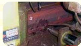
2.穴あけ 鋼材に専用マシンでボルト穴を開けます。
