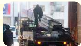
1.材料搬入 大型トラックで鋼材を納入します。
