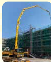
圧送工事風景
