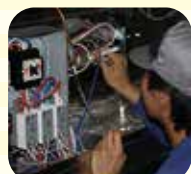
部品組立工程
