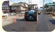
アスファルトを安定させるためローラーで1次転圧
