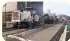
路面切削機で古いアスファルトを削る
