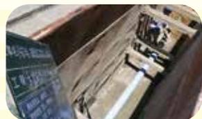
道路を掘り下げ、空いた場所に下水管を埋設します。
